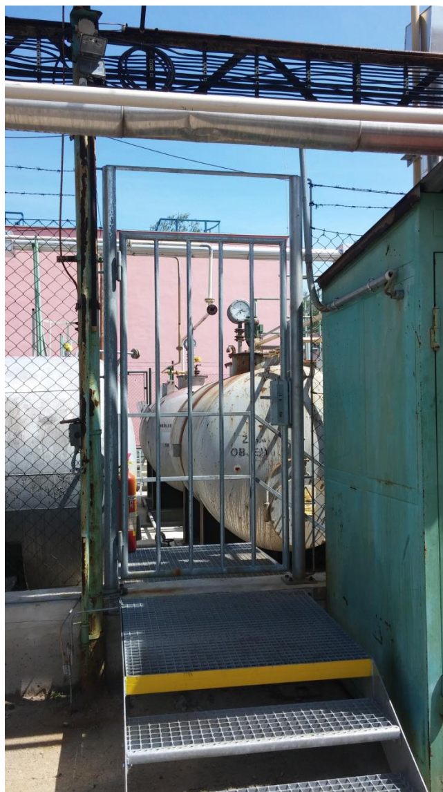
Obr. 7. Vstupní branka do provozního cisterniště (vlastní zdroj)
