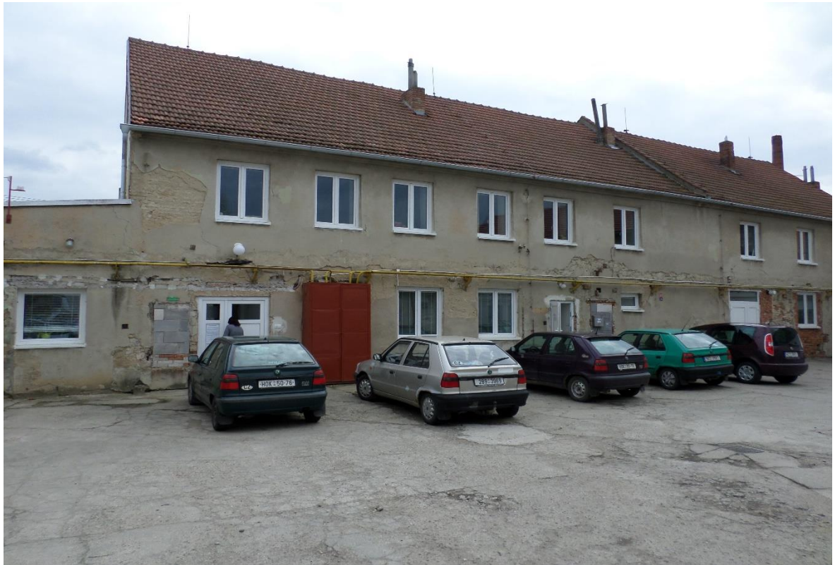
Obrázek 7. Budova TS Kyjov
