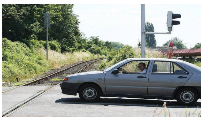
Obrázek 13 Špatný rozhled kvůli přebujelé flóře [14]
