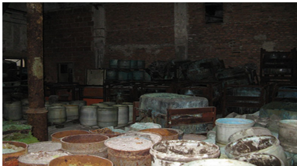
Obrázek č. 12: Současný stav továrny [25]
