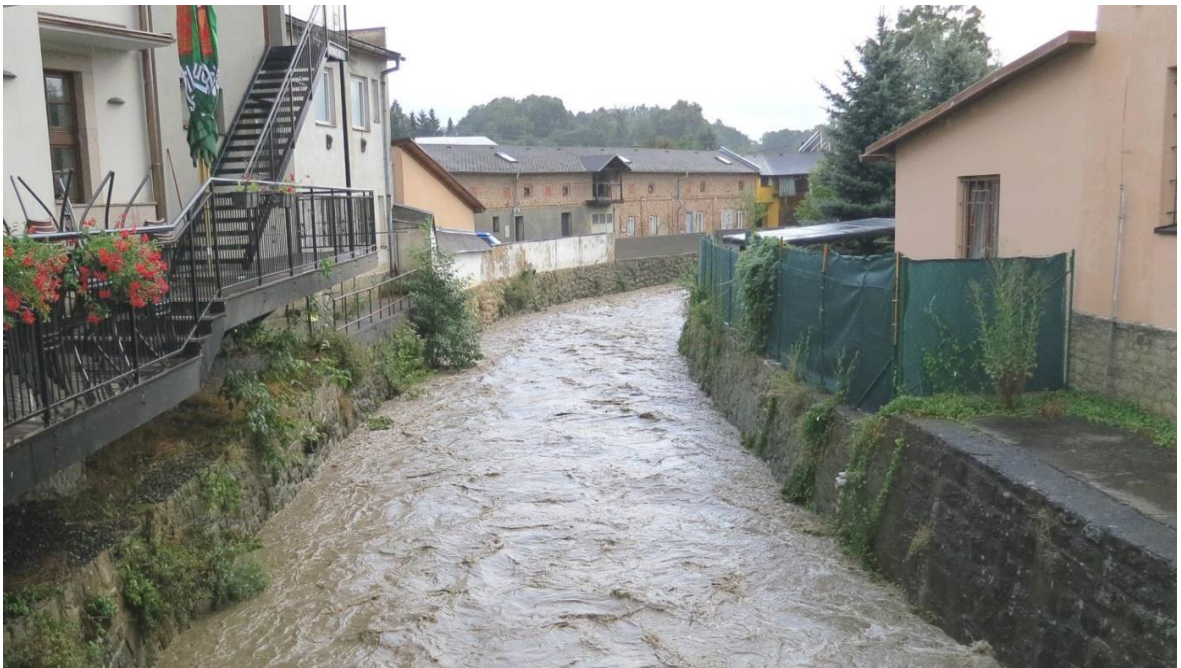
Obr. 18. Rozvodněná Lutonínka ve Vizovicích 2014 [50]
