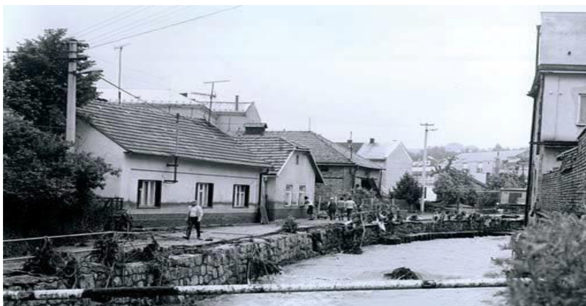
Obr. 5. Zničena ulice Říční [45]
