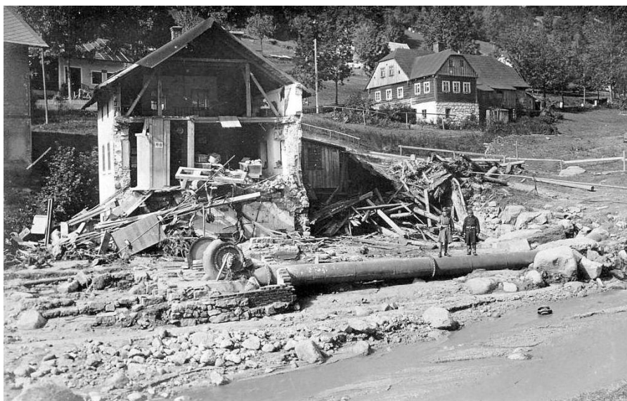
Obrázek 1: Stav obce Desné po protržení hráze 1916 [35]
