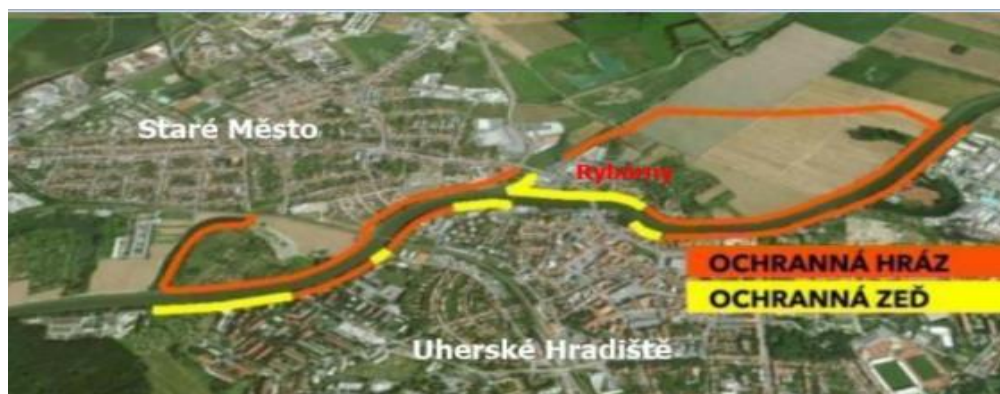
Obrázek 10 Stavba ochranné hráže a ochranné stěny[29]
