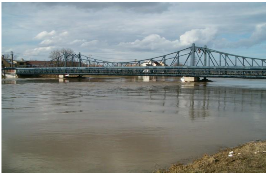
Obrázek 8 Povodeň 2006 Uherské Hradiště – železniční most[35]
