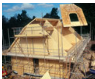
Obr.18. Stavba rodinného domku
