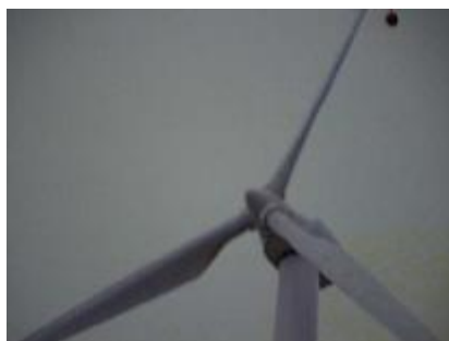
Obr. č.19 : Lopatky větrné elektrárny vyrobené z kompozitních materiálů firmou GERMAN WIND a DENMARK's LM GLASFIBER
