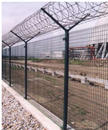
Obr. 10 Bezpečnostní oplocení (svářené zvlnění p. Bastilla)
