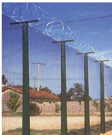
Obr. 11 Vysoko-bezpečnostní oplocení (rovný plot ATLAS)
