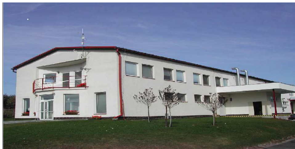
Obr. 7: Fotografie objektu firmy XY
