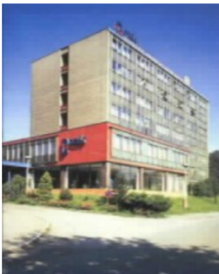
Obr. 5. Hlavní sídlo ORLÍK-KOMPRESORY, v.d. [15]
