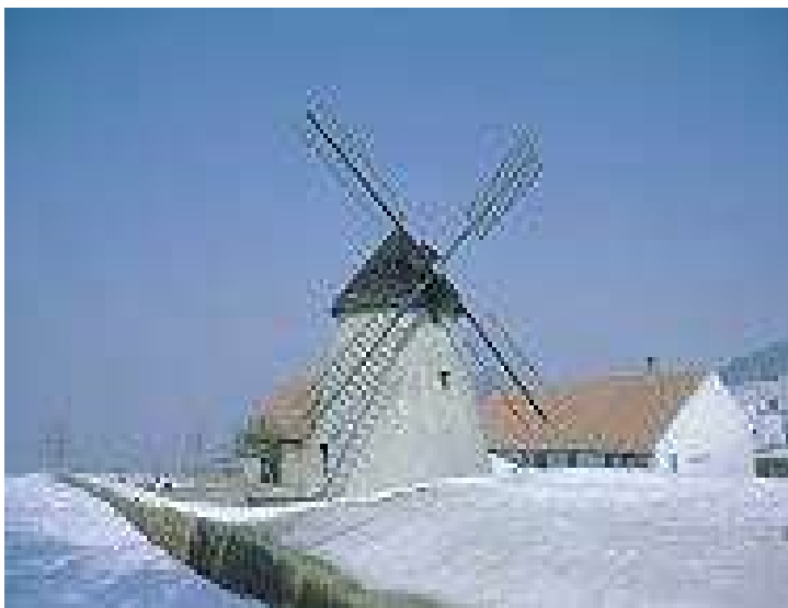
Větrný mlýn v Kuželově
