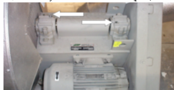
Ložiskové domky hnací hřídele ventilátoru (pos.2)
