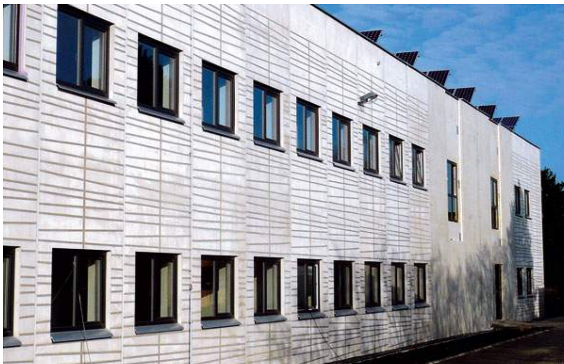
Príloha č.2. Grafický betón na fasáde budovy
