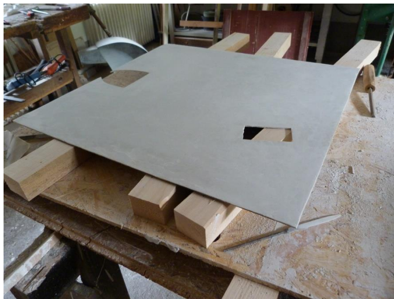
Obrázek 21. Po nanesení sádry s cementem
