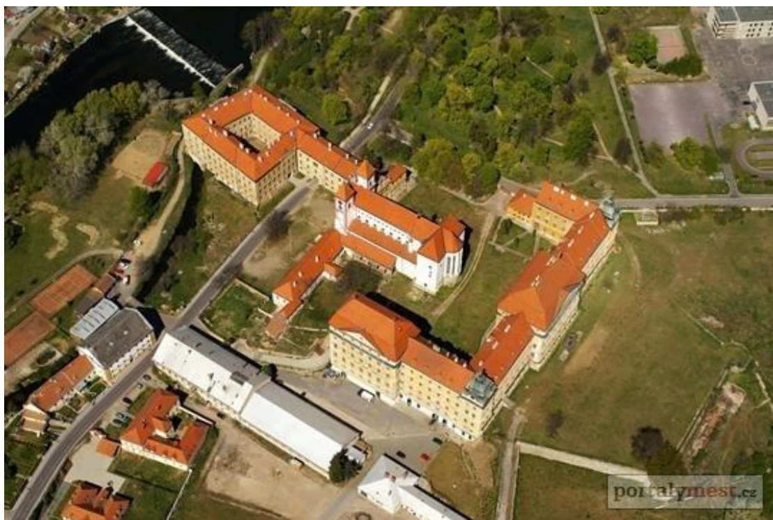
tecký pohled na Loucký klášter (Portály měst, ©2010)
