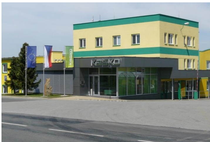
Obrázek 3 Hlavní budova společnosti Kasko, (interní materiály společnosti, 2015)
