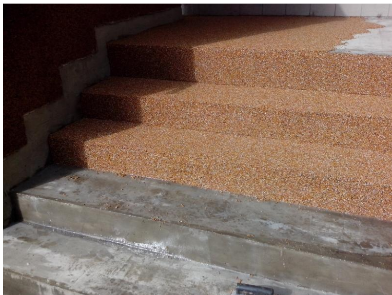
Obr. 18. Tekutá dlažba z polymerbetonu [22]
