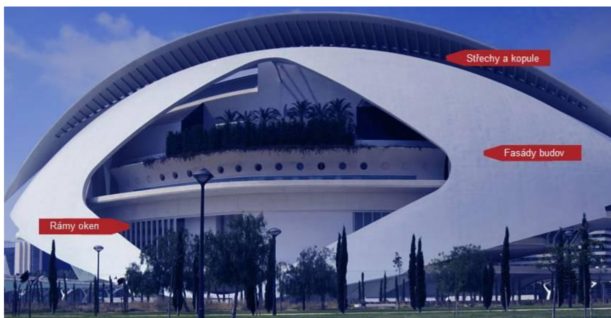
Obr. 22. Příklady použití lehkých sendvičových konstrukcí [37]
