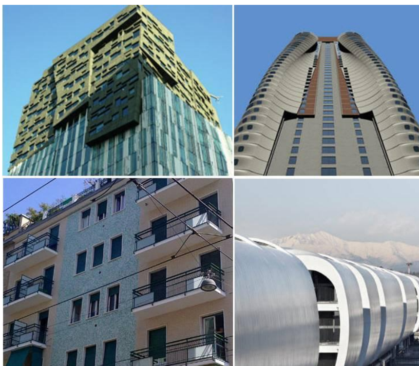
Obr. 24. Aplikace kompozitů na opláštění budov [39]
