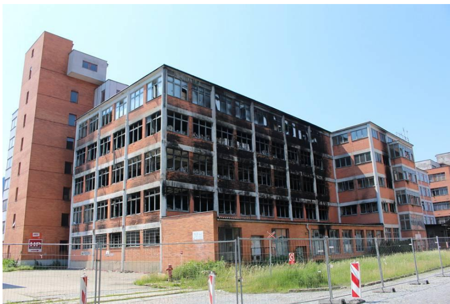
Obr. 17. Monoblok 102. a 103. budovy v bývalém areálu Svit, Zlín [32]
