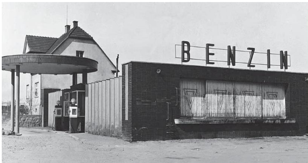
Obrázek 10 Historická čerpací stanice [37]
