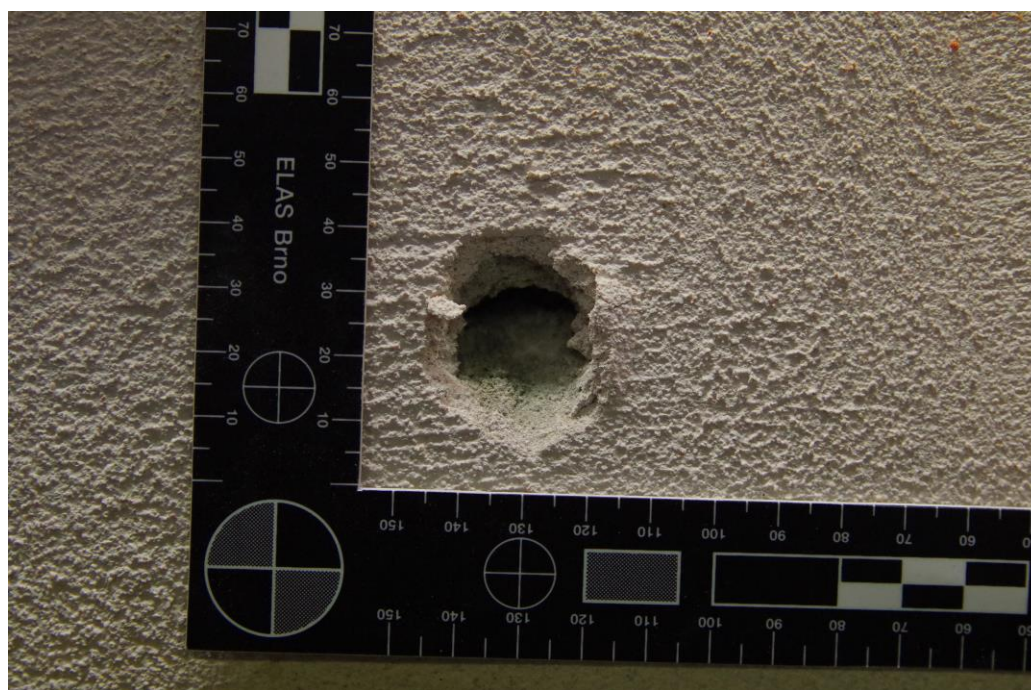
Obr. 37. Vstřelný otvor Pórobeton PorFix s omítkou [Vlastní zdroj]
