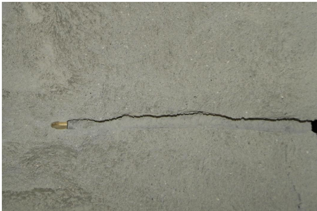
Obr. 35. Střelný kanál v pórobetonu [Vlastní zdroj]
