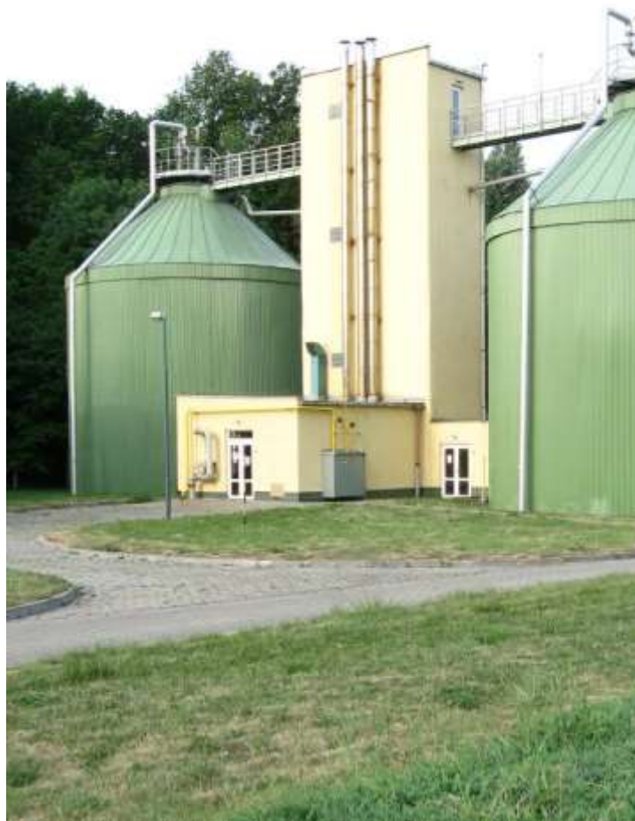
Obr. 5. Fermentační nádrže s kotelnou [foto autor]
