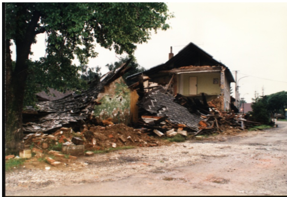
Obrázek č. 21 – Zbořený dům následkem povodně v roce 1997
