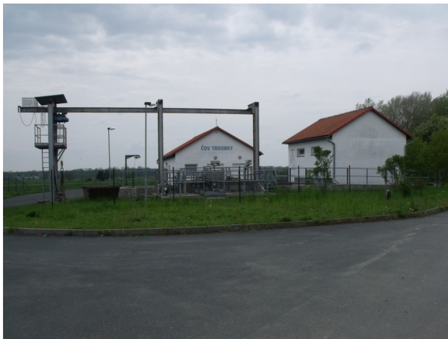
Obrázek č. 12 – Čistička odpadních vod v obci Troubky
