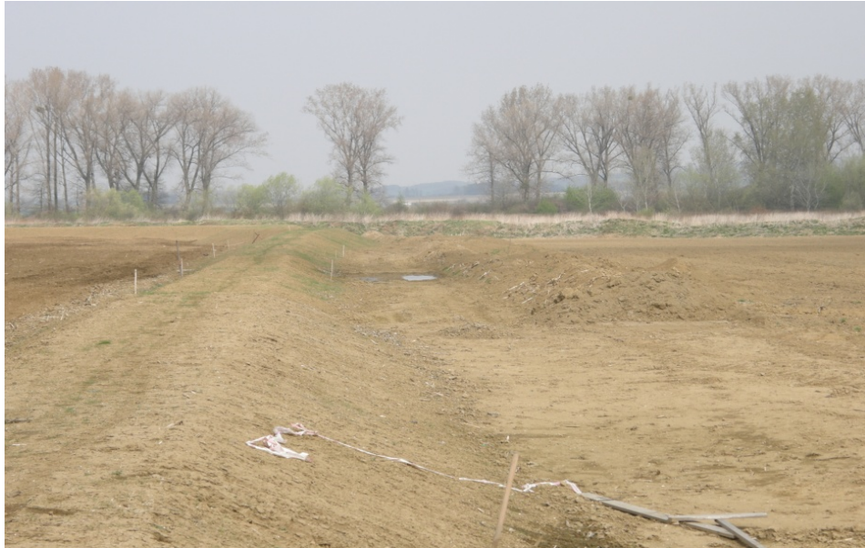
Obrázek č. 16 – Výstavba protipovodňového opatření v lokalitě Závalí
