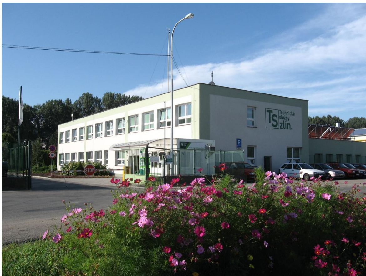
Obr. 1. Budova vedení společnosti TS Zlín, s.r.o. [28]
