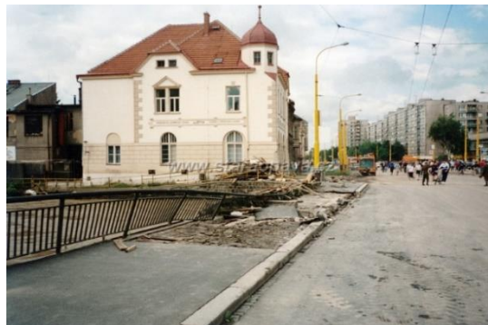
Obr. 20 Povodňové škody v roce 1997, most v městské části Kateřinky [Zdroj:[40] ]
