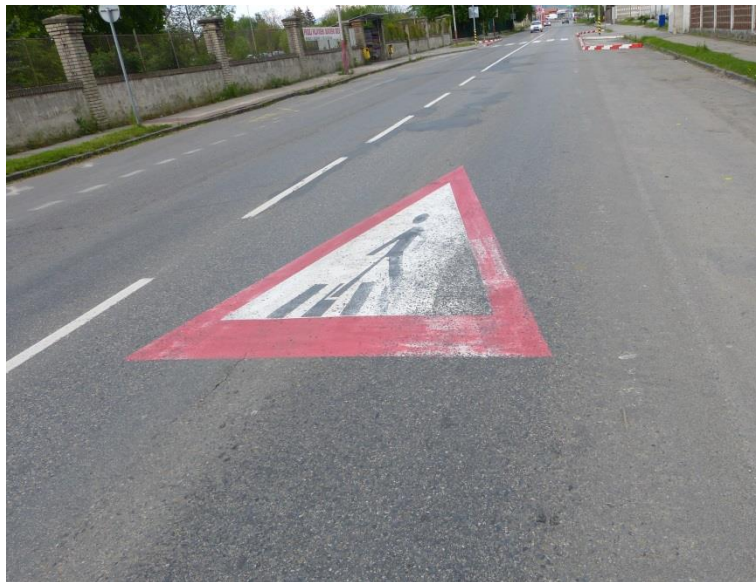
Obr. 11. Vodorovné značení přechodu pro chodce, Zdroj: [vlastní]
