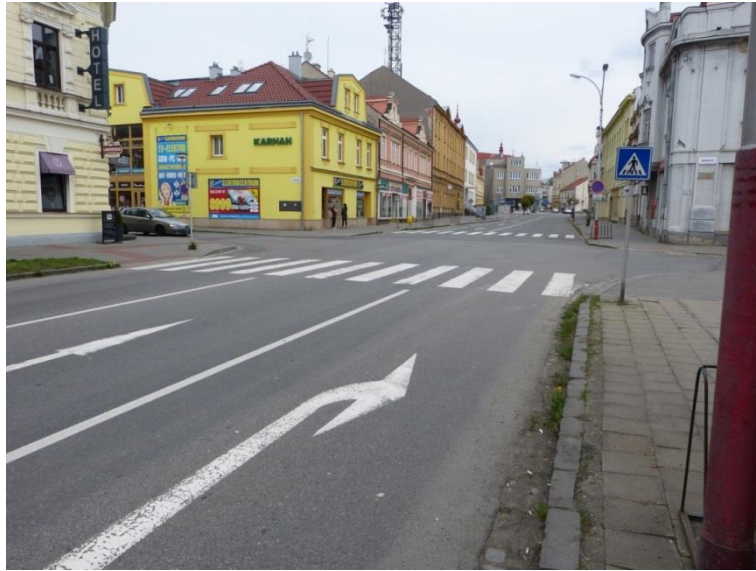
Obr. 10. Aktuální stav na křižovatce ulic Nerudova, Palackého, Grohova, Zdroj: [vlastní]
