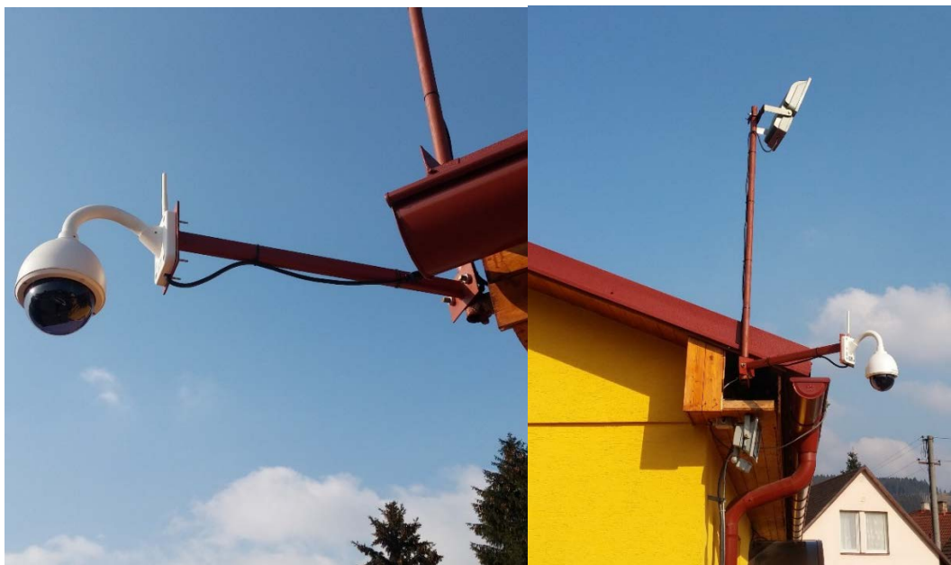
Obr. 30. Venkovní IP kamera Foscam FI9828P – montáž.
