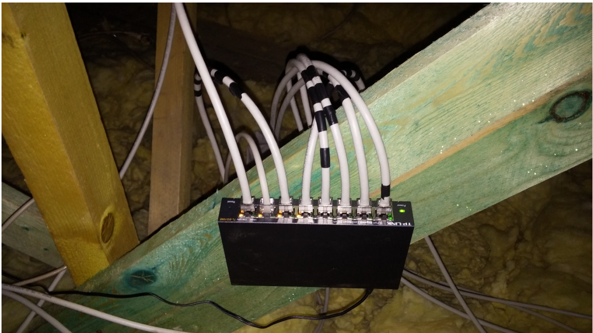
Obr. 29. L2 switch TP-LINK TL-SG108E – zapojení.
