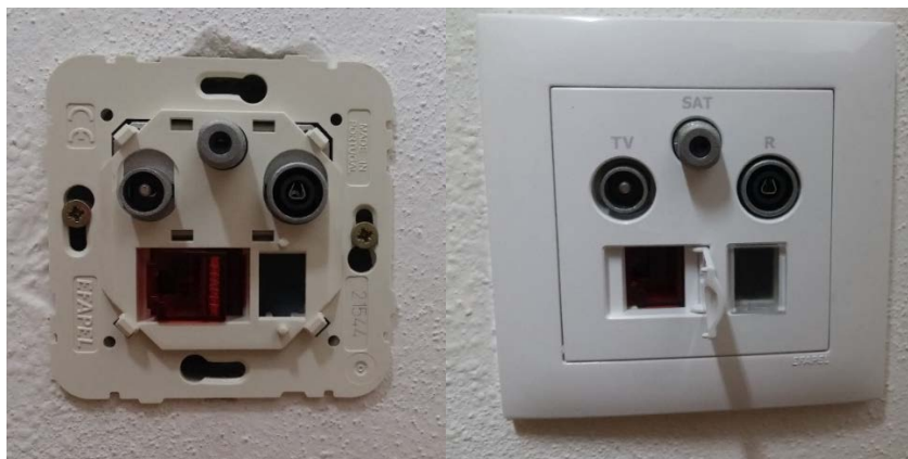
Obr. 23. Instalace zásuvky ELKO EP 21544.
