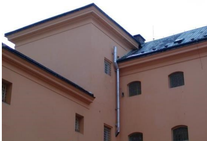
Obr. 8. Mříže a pletiva v oknech Vazební věznice Liberec
