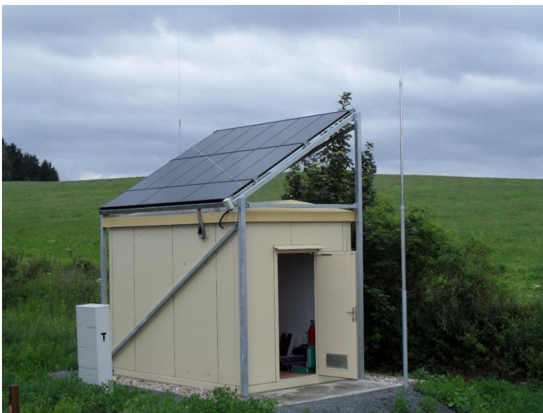
Obr. 22. Reléový domek s konstrukcí pro FV panely
