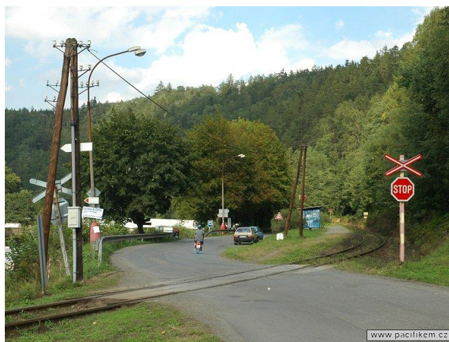
Obr. 1. Pasivně zabezpečený žel. přejezd
