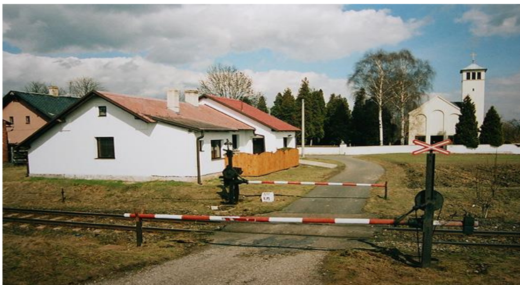
Obr. 2. Železniční přejezd zabezpečen PZM 1
