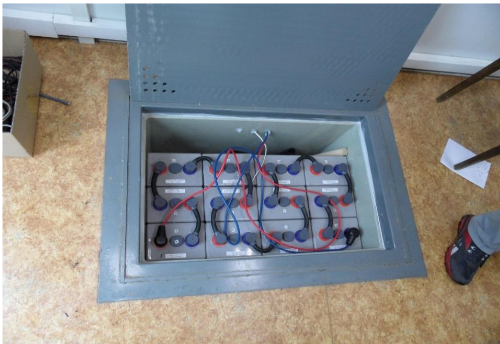
Obr. 23. Bateriová studna
