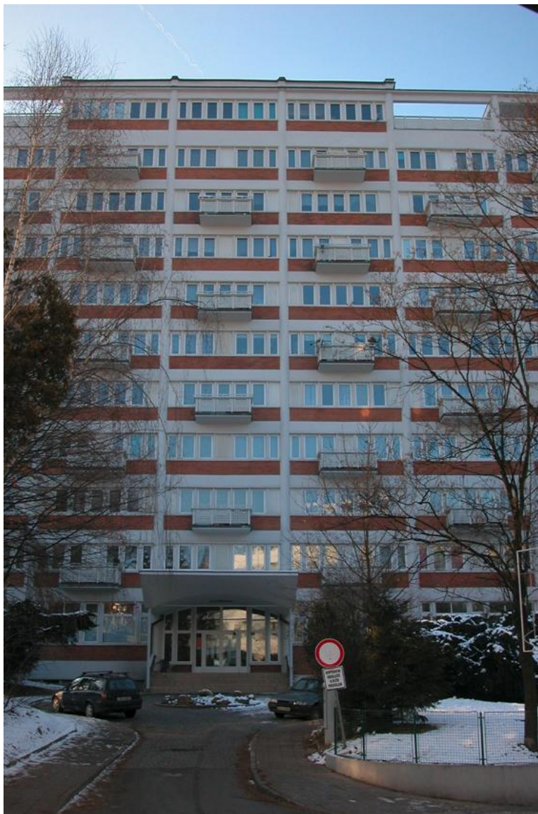
Čelní pohled na Alternativu – kulturní institut Zlín (Kolektivní dům)
