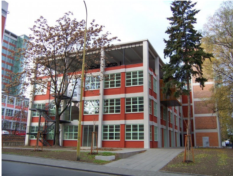
Obr. 21. Budova Technologického inovačního centra (zdroj: www.svtp.cz )
