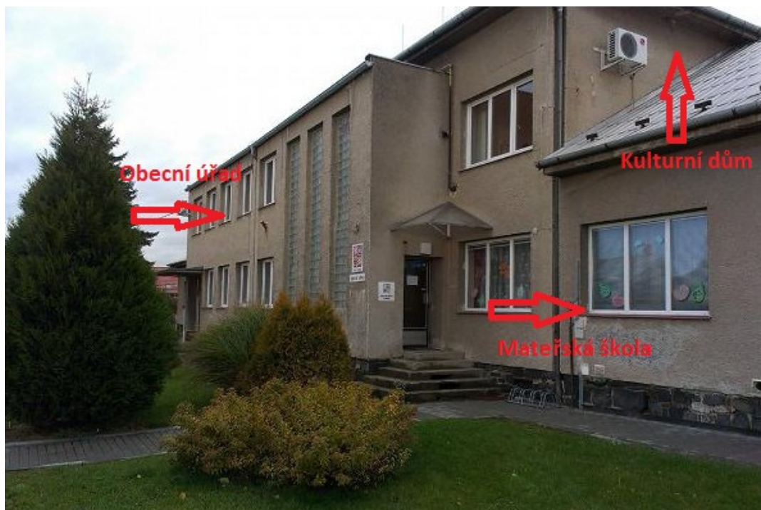
Obrázek 11: Budova obecního úřadu, MŠ a kulturního domu v Tověři
