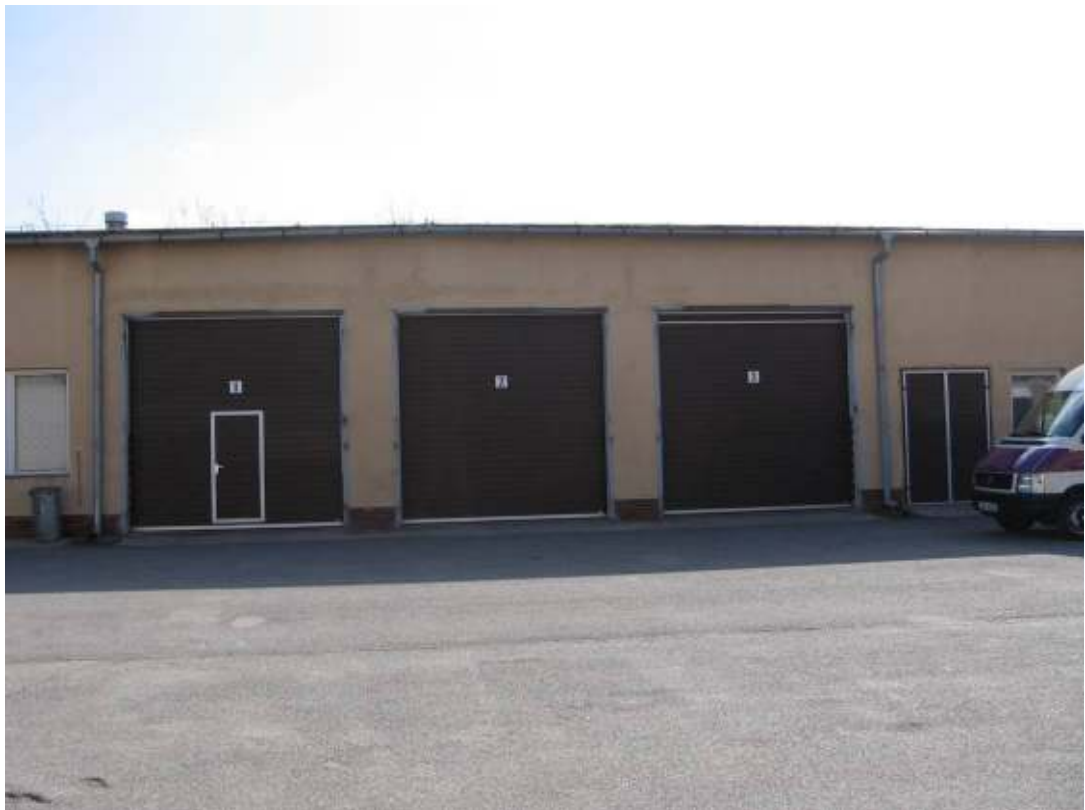
V roce 2006 dokončená výměna vjezdových vrat do služebních garáží
