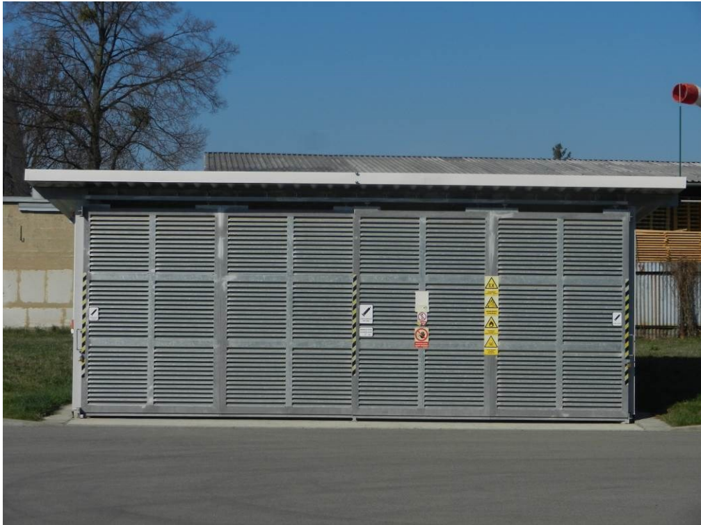
Obrázek 9 - Venkovní sklad ethylenoxidu [zdroj: vlastní]
