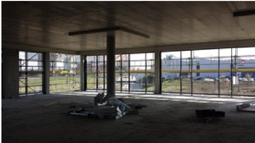
Obrázek 7 Stavební práce v zóně C [17]
