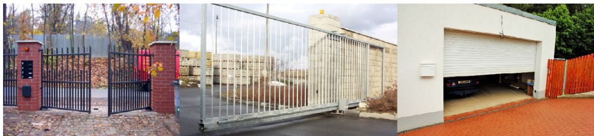
Obrázek 7. Typy bran zleva otočné [13] posuvné [14] a výsuvné. [15]
