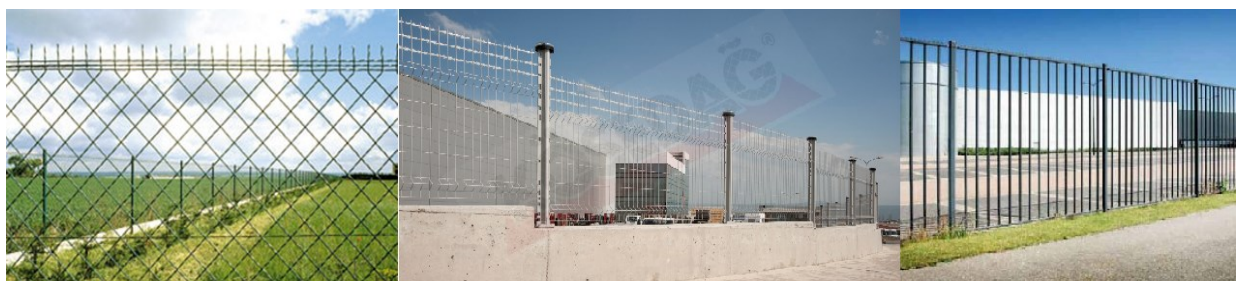
Obrázek 3. Bezpečnostní oplocení zleva pletivo z vlnitého drátu [6], svařované zvlňené pletivo [7] a mřížové oplocení. [8]
