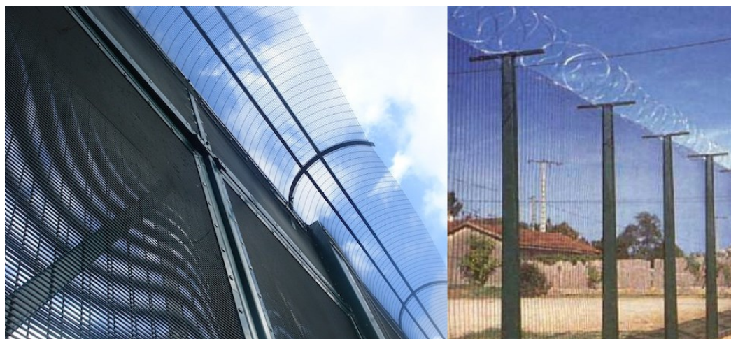
Obrázek 5. Vysoce bezpečnostní oplocení zleva zakřivený plot FST [11] a rovný Atlas. [10]
