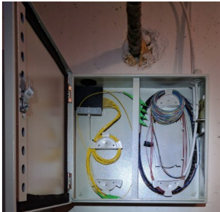
Obr. 38. Distribučný box v suteréne.
