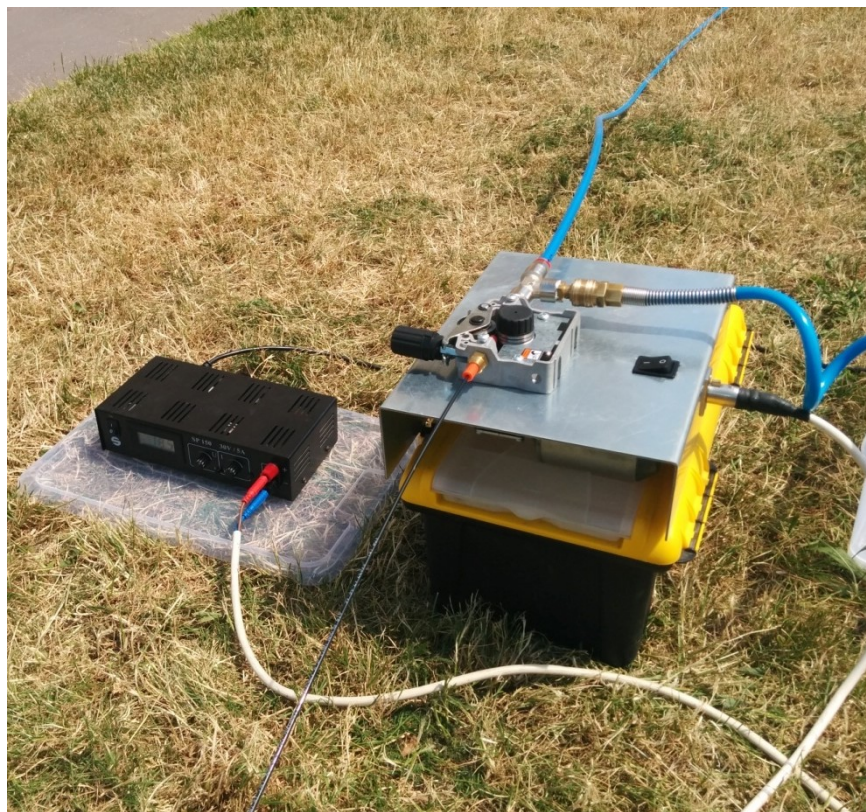
Obr. 32. Zafukovanie optického kábla.
