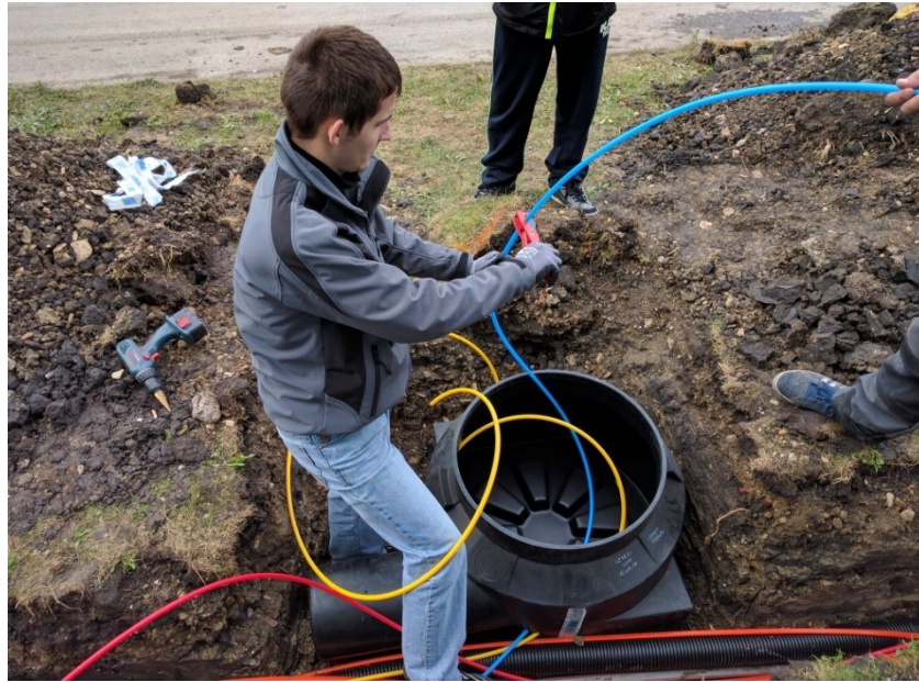
Obr. 28. Inštalácia trubičiek do boxu.
