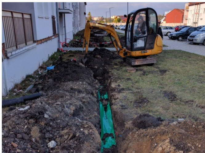
Obr. 31. Zakopávanie výkopu.
