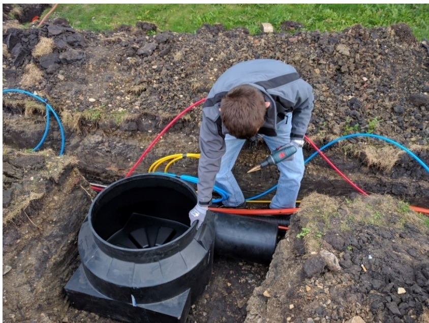
Obr. 27. Inštalácia zemného boxu.
