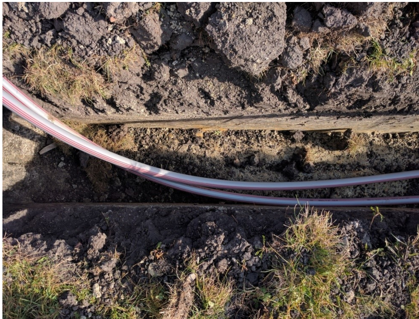
Obr. 25. Výkop na sídlisku s pokládkou.
