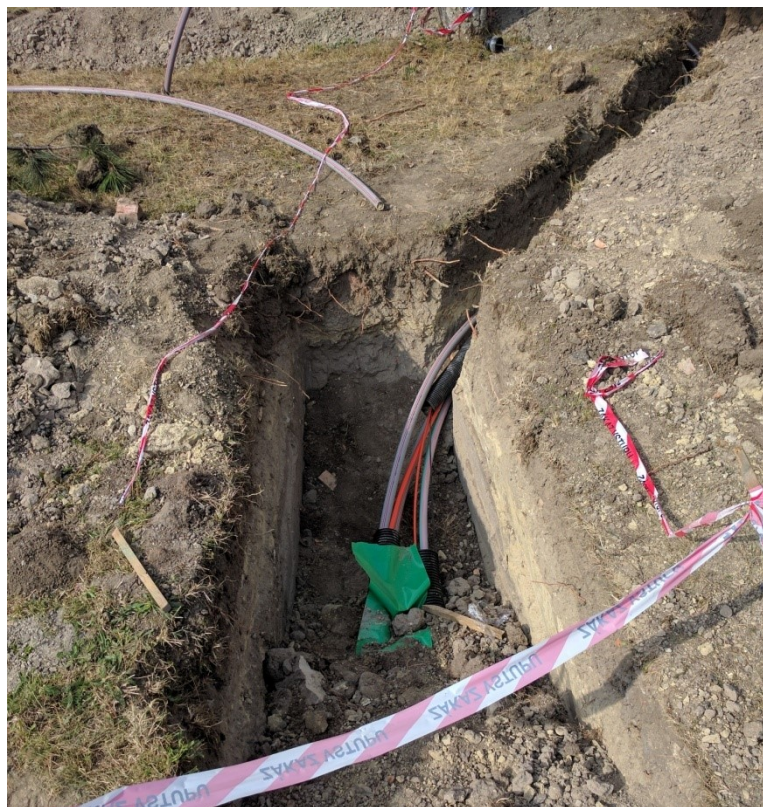
Obr. 29. HDPE ako ochrana mikrotrubičiek.
