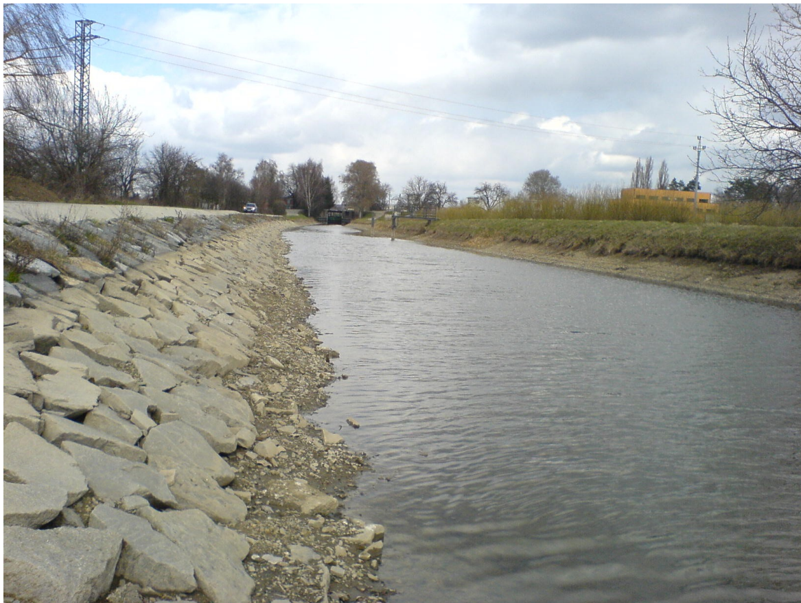
Obr. 8: Břeh zpevněný pomocí kamenů [30]
