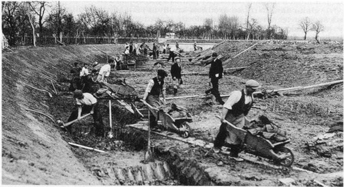
Práce na korytě kanálu mezi Spytihněví a Uh. Hradištěm v dubnu r. 1935, snímek J. Vaňhara
