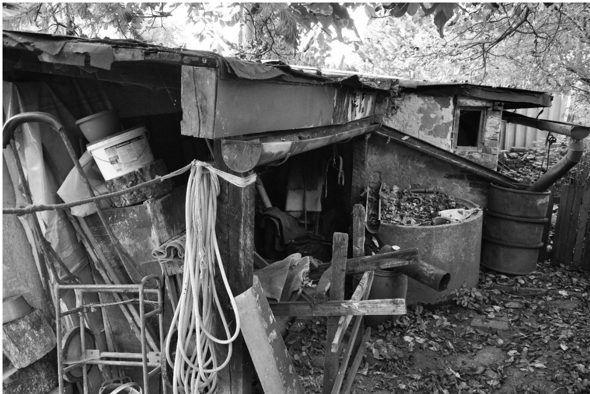
Obr. 1 Přístřešek za dědovou garáží a systém na sběr vody
