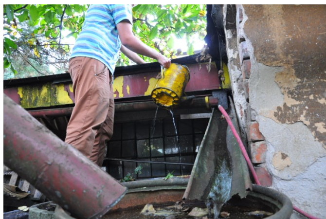
Obr. 34 Zkouška dešťového systému
