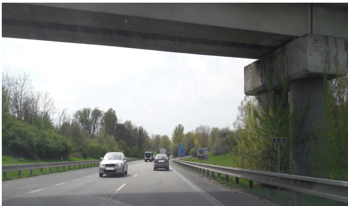
Obr. 8 I/55 – křižovatka s II/380, v provedení MÚK. [2017-04-25]. Zdroj: autor.
