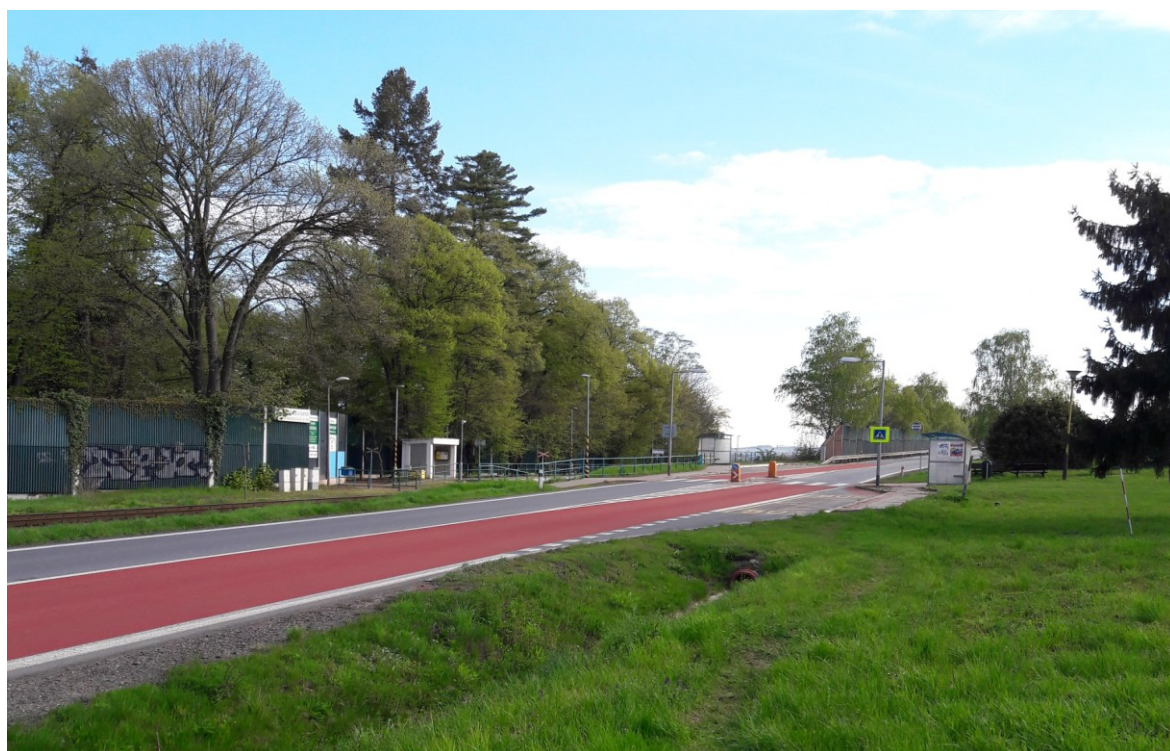
Obr. 4 I/55 – Ostrožská Nová Ves, sirnaté lázně, úsek 50km.h -1 . [2017-04-25]. Zdroj: autor.
