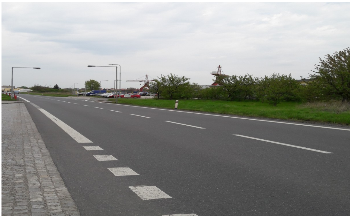
Obr. 5 I/55 – úsek Veselí nad Moravou → Uherský Ostroh. [2017-04-25]. Zdroj: autor.
