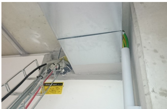
Obr. 23. Netěsnost č. 5 - Prostupy husích krků s požární ucpávkou a štítkem [Zdroj: vlastní]
