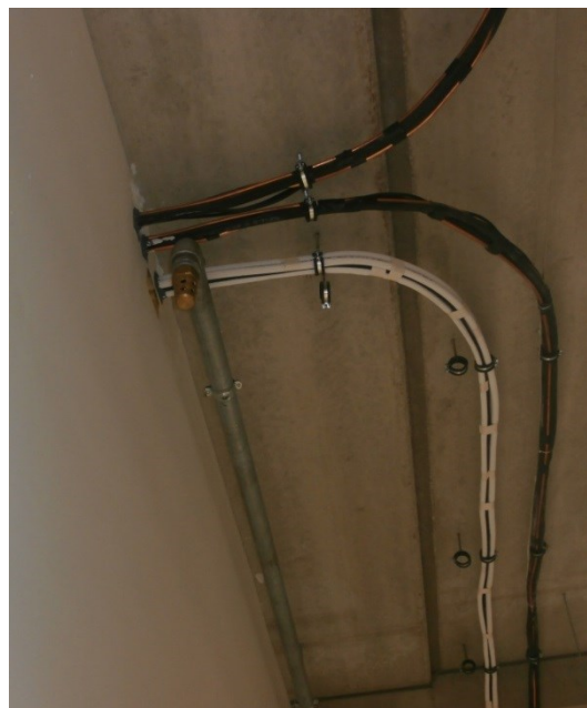
Obr. 16. Potrubní rozvod s výstřikovou koncovkou [Zdroj: vlastní]
