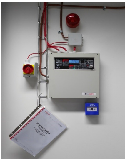
Obr. 13. Ústředna plynového SHZ [Zdroj: vlastní]
