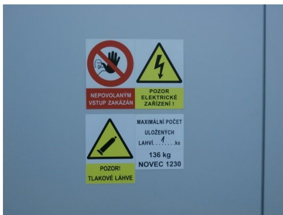
Obr. 12. Bezpečnostní tabulky na vstupních dveřích chráněného prostoru [Zdroj: vlastní]
