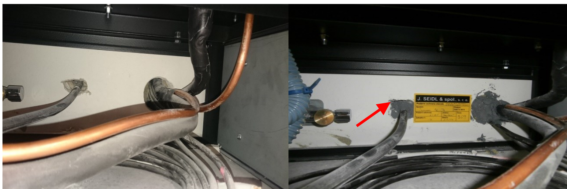
Obr. 50. Oprava prostupů kabelů elektroinstalace [Zdroj: vlastní]
