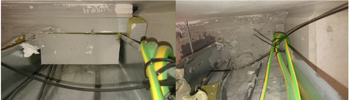
Obr. 52. Oprava průstupů kabelů elektroinstalace [Zdroj: vlastní]
