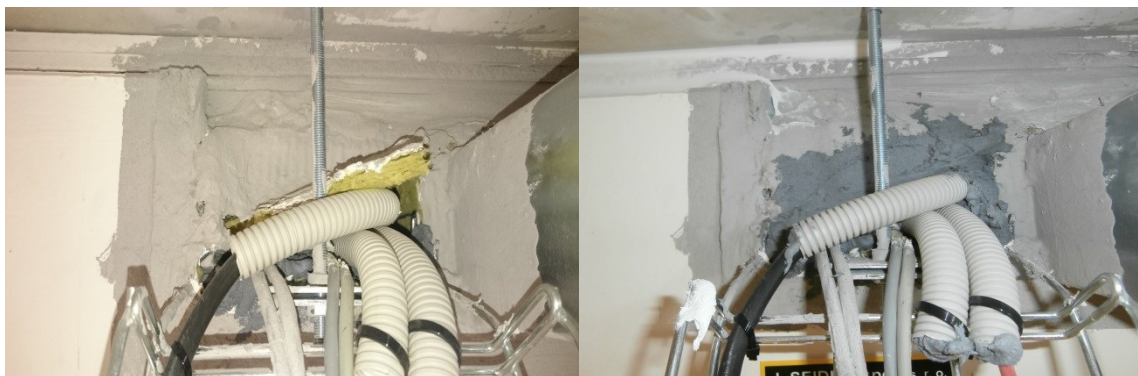
Obr. 51. Oprava prostupu husích krků [Zdroj: vlastní]
