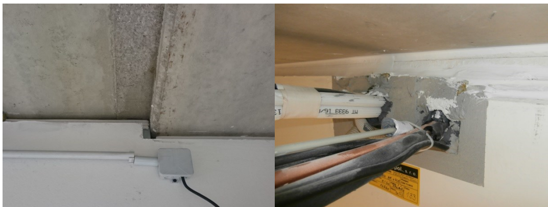
Obr. 49. Oprava netěsnosti mezi stropem a příčkou [Zdroj: vlastní]
