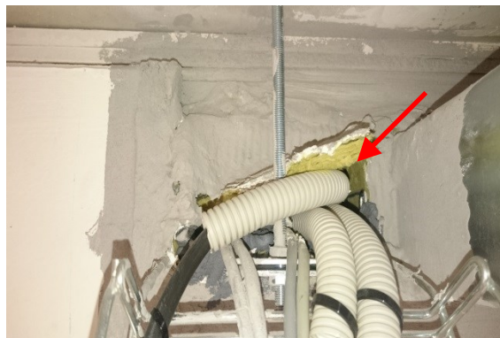
Obr. 24. Netěsnost č. 6 – Prostupy husích krků [Zdroj: vlastní]
