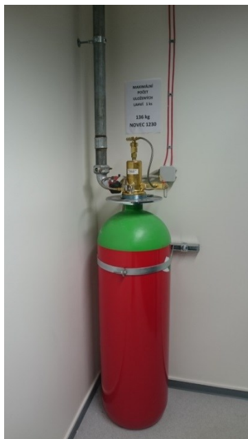
Obr. 15. Tlaková láhev s hasivem [Zdroj: vlastní]
