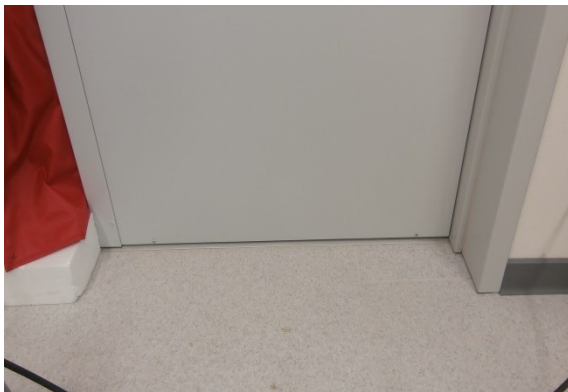
Obr. 35. Mezera pod dveřmi [Zdroj: vlastní]
