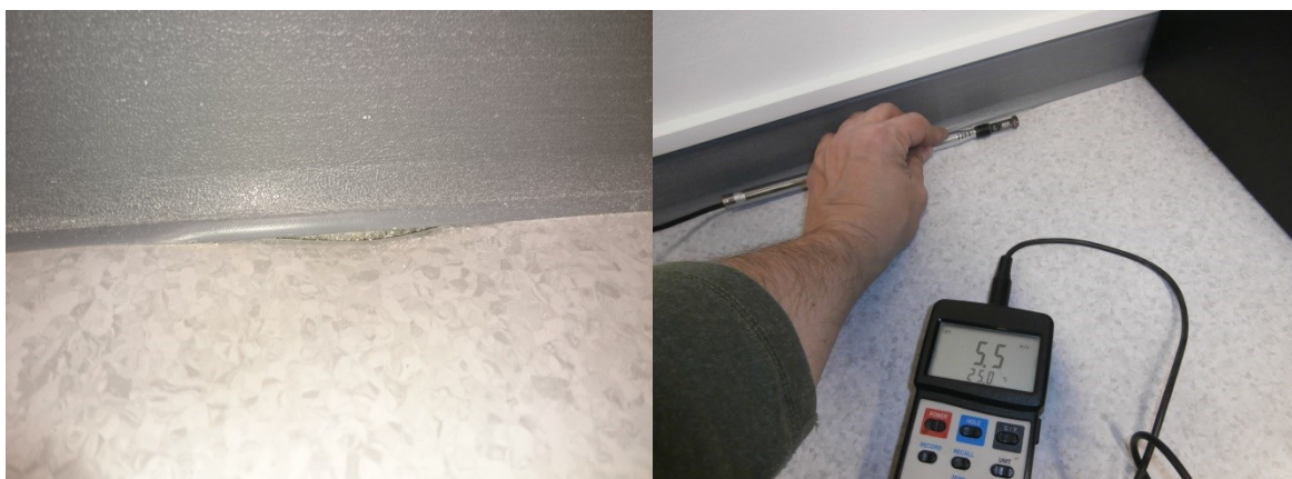
Obr. 54. Oprava prostupu pod podlahovou lištou [Zdroj: vlastní]
