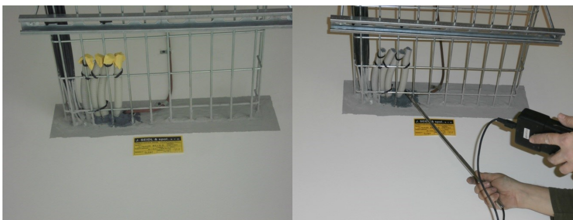
Obr. 55. Oprava zatmelením husích krků [Zdroj: vlastní]
