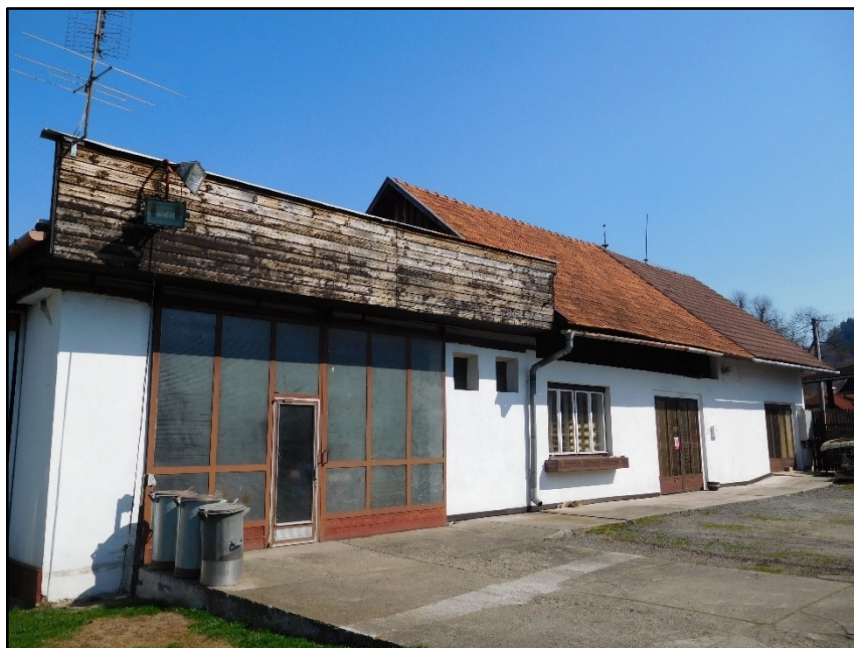
Obr. 6. Budova A [vlastní]
