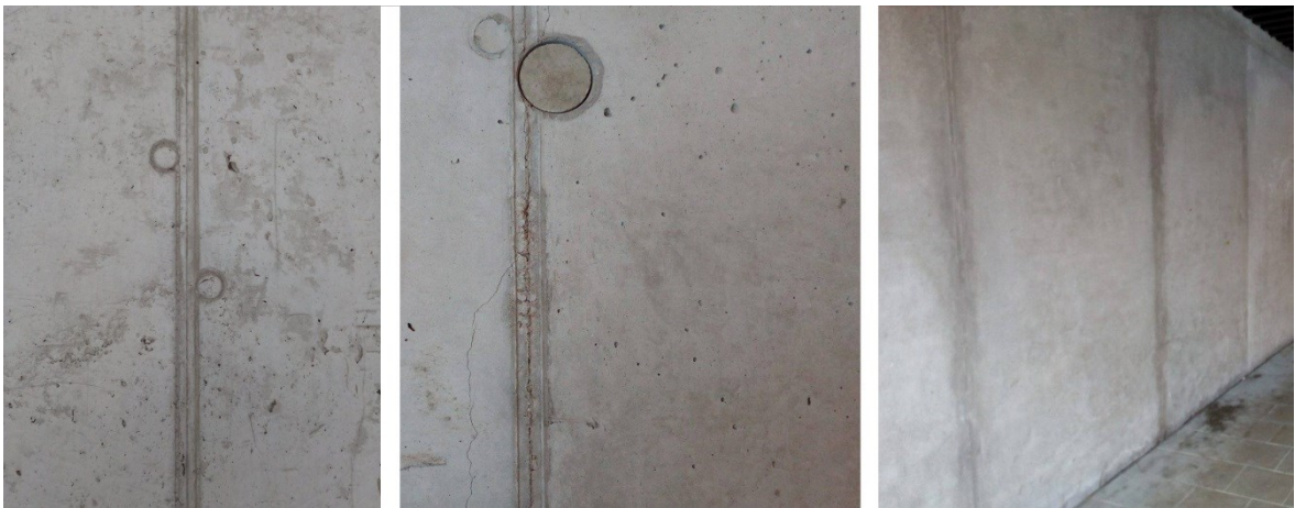
Obr. 59 Detail pohledového betonu
