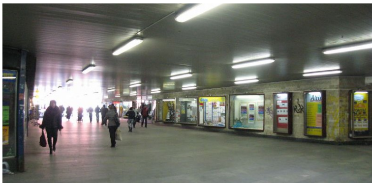
Obr. 3 Podchod / před rekonstrukcí
