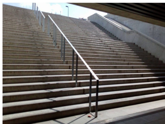
Schodiště a nové zábradlí
