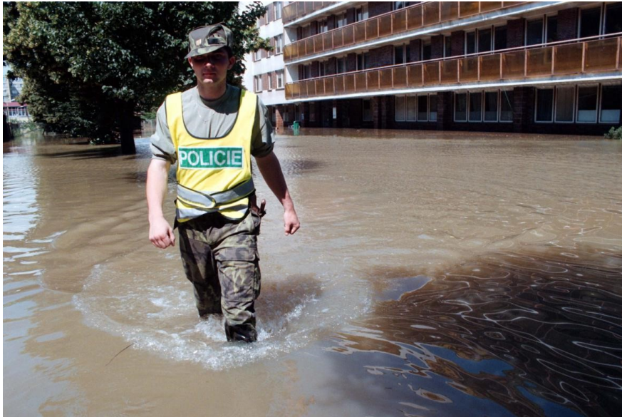
Obr. 11 Povodeň 1997, zatopeno přízemí budovy kde sídlí interní JIP
