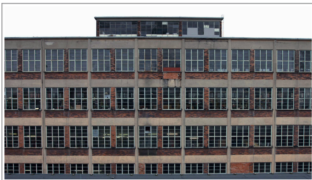
Obr. 5: 44. budova bývalého bat'ovského továrního komplexu, zdroj: soukromý archiv
