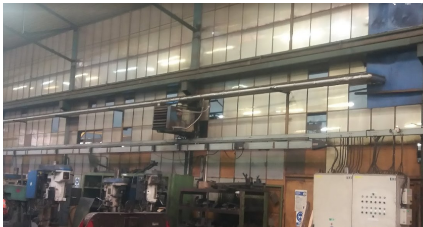
Obr. 9: Prosklená zeď haly (Zdroj: vlastní zpracování)
