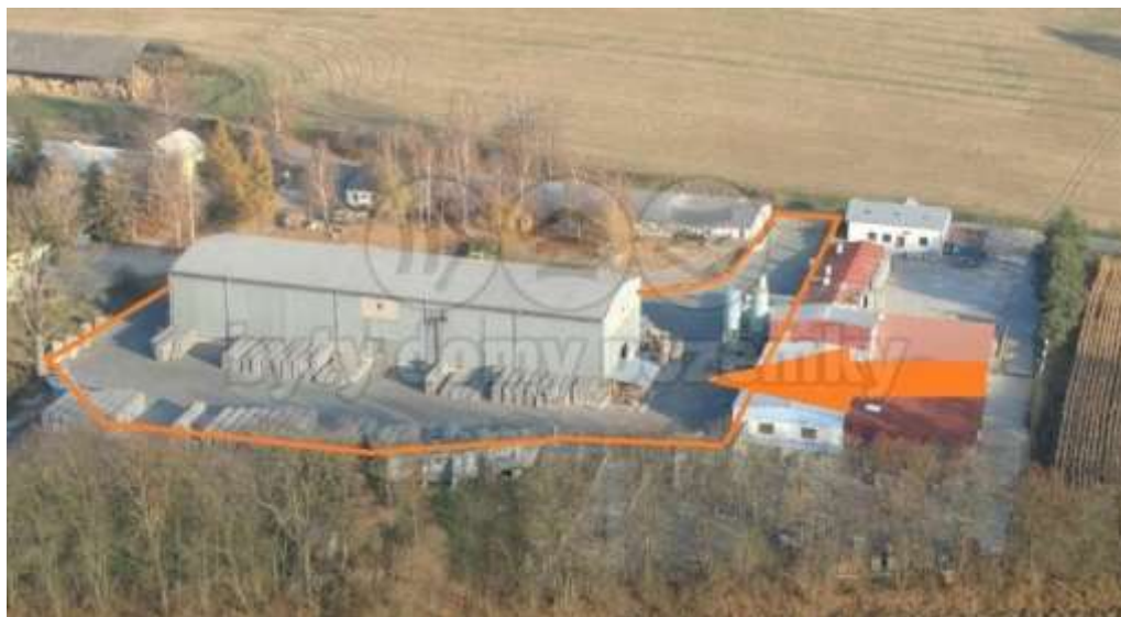
Obr. 4. Skladovací hala v Mysločovicích (Nemovitosti, © 2016)
