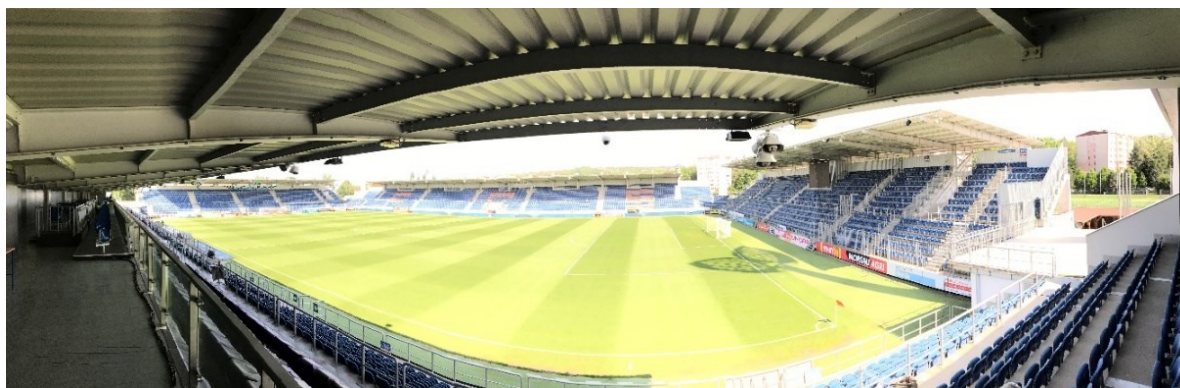
Obr. 9 Stadion Miroslava Valenty v Uherském Hradišti
