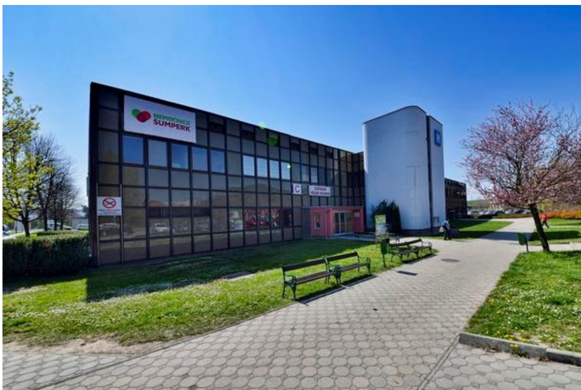
Obr. 1 Hlavní budova Nemocnice Šumperk (zdroj: www.sumperk.cz , 2018)
