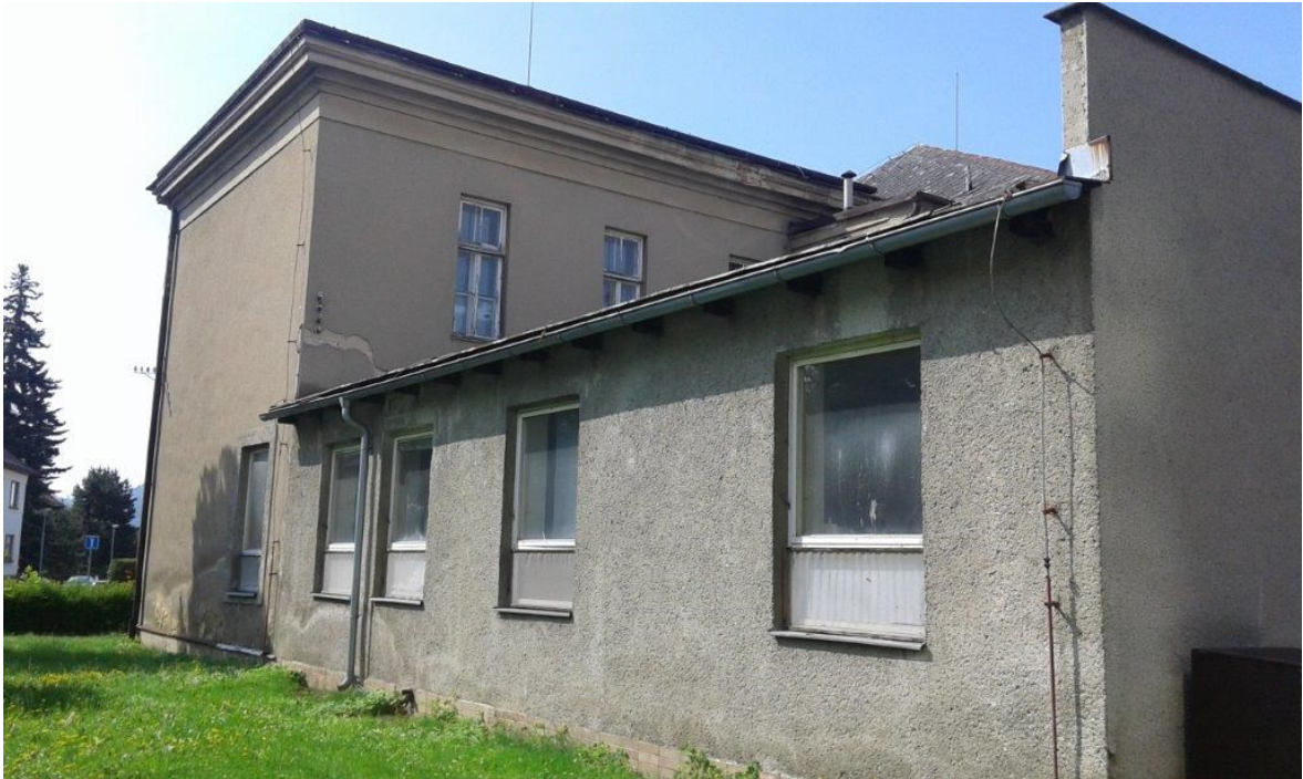
Obr. 4 Budova firemní mateřské školy před rekonstrukcí (zdroj: vlastní fotografie)
